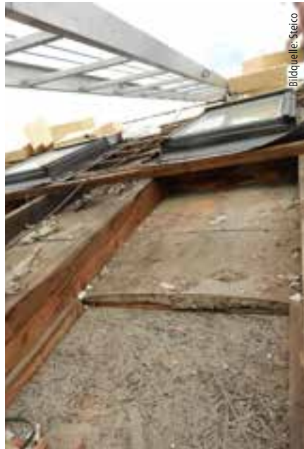
Im genutzten Bereich befindet sich unterhalb der Sparren eine raumseitig verputzte Schilfrohrmatte, darüber eine dünne Schicht Mineralfaser-Dämmung, bedeckt mit Dachpappe, im Bereich des Kniestocks nur eine Heraklitplatte.
