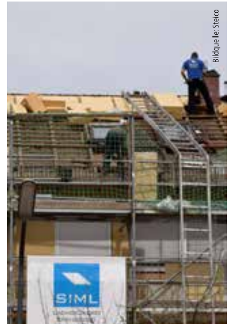
Nach dem Abdecken füllten die Dachdecker als erstes den Zwischensparrenbereich mit einer Holzfaser-Dämmmatte.
