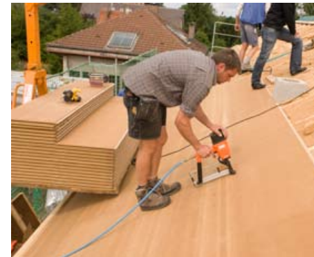
STEICO universal Unterdeckplatte (Behelfsdeckung, zusätzliche Dämmebene und winddichtende Schicht)
