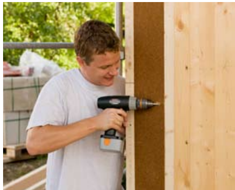
Einfache und kostengünstige Direktbefestigung des STEICO wall Dämmträgers durch den hinteren Gurt
