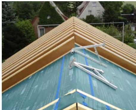
Dachkonstruktion mit STEICO joist Dämmträgern (Wärmebrücken-optimierte Tragkonstruktion)
