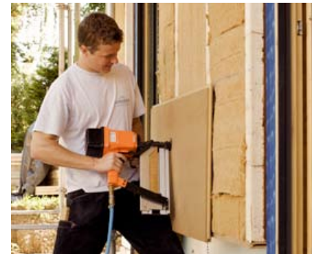
Befestigung der Unterdeckplatte STEICO universal (Lastabtrag der kompletten Fassadenlast über den äußeren Gurt)
