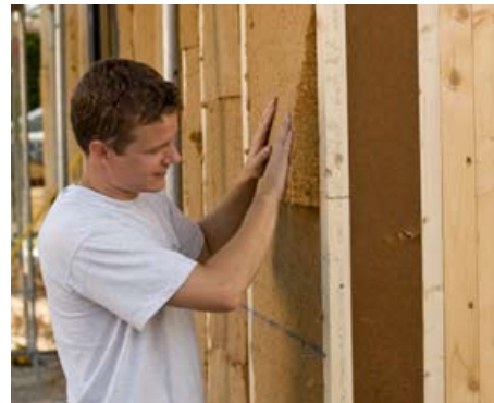
Passgenaues Einbringen der flexiblen Holzfaser-Dämmung STEICO flex
