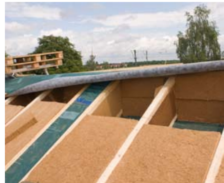
STEICO flex Hohlraumdämmung (flexibel, diffusionsoffen, sehr guter sommerlicher Hitzeschutz)
