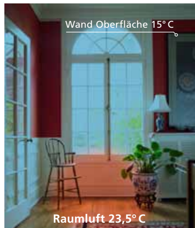
Vor der Innendämmung: Kalte Wände – unbehaglich trotz hoher Raumtemperatur.
