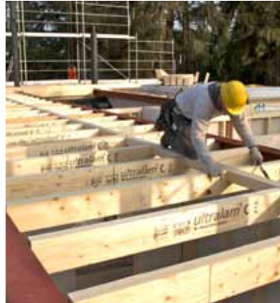
STEICOultralam R™ als besonders tragfähiges Deckenbauteil.
