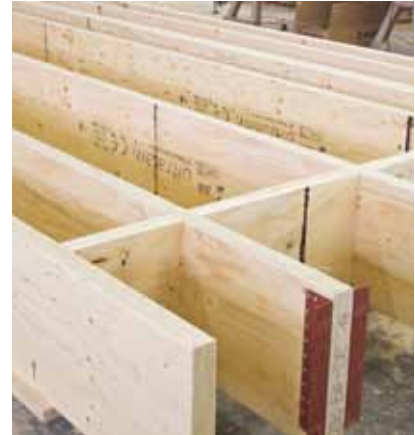
Vorfertigung von Holhkasten-Deckenelementen.
