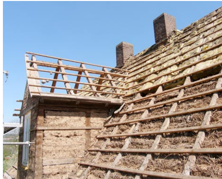
Dachfläche vor der Sanierung (bereits ohne Ziegeleindeckung)
