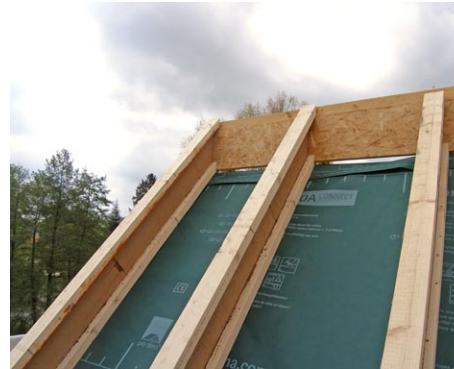
STEICOjoist Dachträger auf bestehenden Sparren (Wärmebrückenoptimierung) Die Zwischenräume werden mit STEICOzell ausgedämmt.
