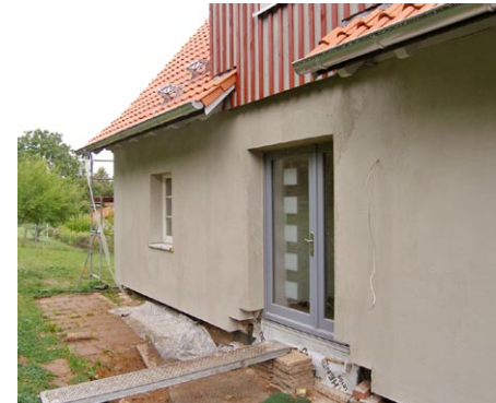
Verputzen der Fassade. Der Auftrag des Unterputzes (mit Gewebe) erfolgt direkt auf den STEICOprotect Holzfaser-Dämmplatten.
