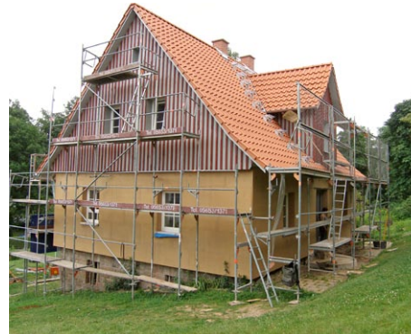
Während der untere Fassadenbereich noch verputzt wird, wurde der Giebelbereich bereits mit einer Holzschalung versehen.
