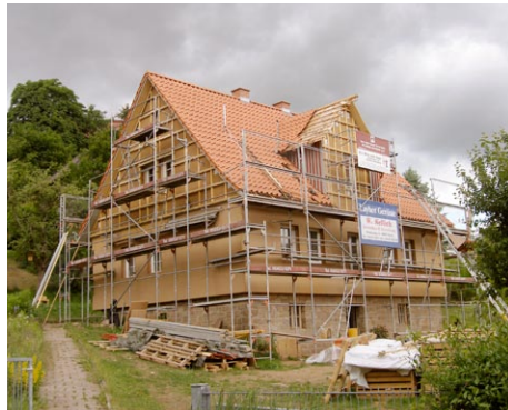
Das Dach ist fast fertig. Die ausgedämmte Fassade ist bereits mit den Putzträgerplatten STEICOprotect beplankt.
