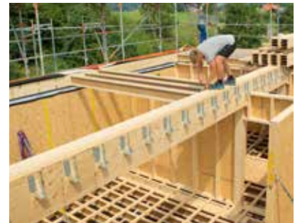
STEICO G LVL R jako hlavní nosník (náhrada oceli)
