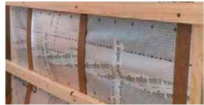
Når man lægger membranen på tværs, anbefales det at forstærke overlappingsklæbningen yderligere midt i området med STEICOm<sup>ulti</sup> tape-stykker
