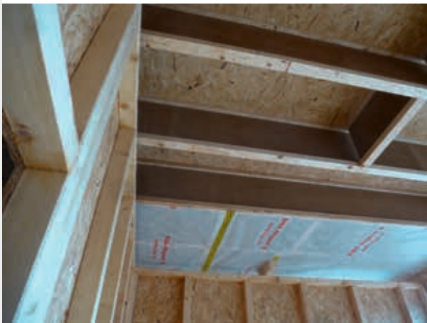
Poutres en I STEICOjoist pour les planchers : la légèreté des poutres en I permet de réaliser des éléments de grande portée. Un isolant en vrac est insufflé entre les solives. La finesse des poutres permet de réduire les ponts thermiques.
