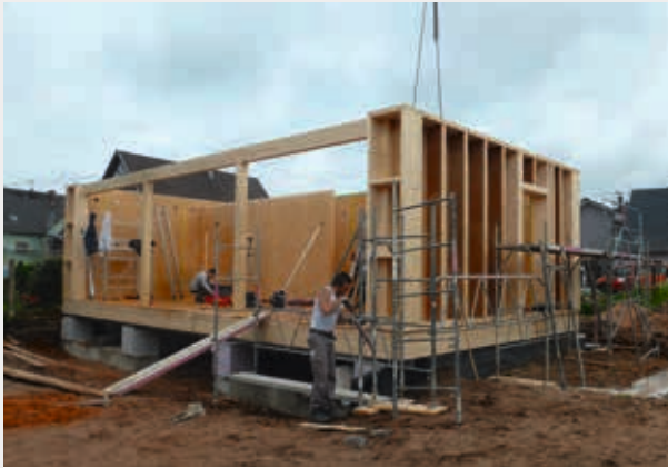
Plancher bois sur pilotis béton. Les poutres de plancher et les montants des murs extérieurs sont en STEICOjoist. Les lisses et les linteaux sont en lamibois STEICO LVL. Les éléments sont préfabriqués en atelier et assemblés sur le chantier.
