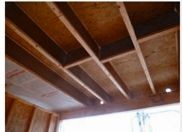
Poutres en I STEICOjoist pour les planchers : la légèreté des poutres en I permet de réaliser des éléments de grande portée. Un isolant en vrac est insufflé entre les solives. La finesse des poutres permet de réduire les ponts thermiques.
