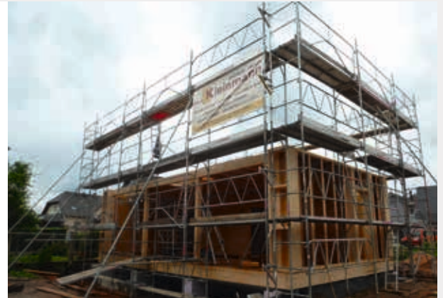
Plancher bois sur pilotis béton. Les poutres de plancher et les montants des murs extérieurs sont en STEICOjoist. Les lisses et les linteaux sont en lamibois STEICO LVL. Les éléments sont préfabriqués en atelier et assemblés sur le chantier.
