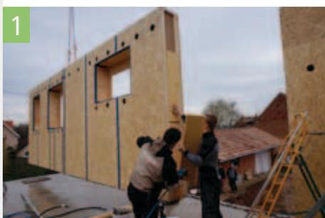
1 La légèreté des éléments structurels facilite le transport et la mise en œuvre sur le chantier.
