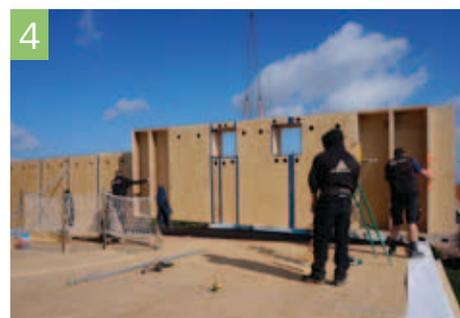
4 Construction du deuxième étage. Le poids de l'étage est soutenu par les murs extérieurs et les cloisons porteuses. La structure est beaucoup plus légère qu'une maison en maçonnerie.
