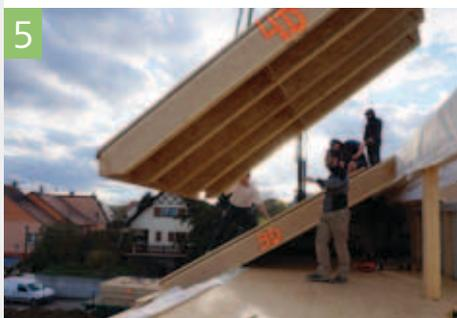
5 On retrouve les poutres en I STEICOjoist dans la toiture. Les poutres extérieures des éléments de préfabriqués sont préisolées. Cela permet d'éviter un pont thermique entre les âmes de deux poutres juxtaposées.
