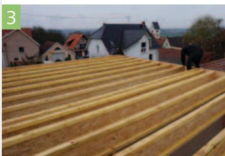
3 Plancher en STEICOjoist. La longueur des poutres en I permet de réaliser des éléments de grande portée.
