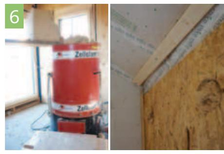
6 L'isolant en vrac STEICOzell est insufflé entre les chevrons et entre les montants des murs. En construction bois, l'isolant se trouve dans l'ossature, ce qui permet d'éviter les ponts thermiques et de gagner en surface habitable.
