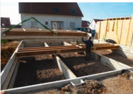
Les poutres en I STEICO sont légères et faciles à manier pour un confort de travail accru sur le chantier et une avancée rapide des travaux.
