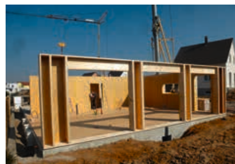
Les montants des ouvertures sont en STEICO LVL pour une meilleure reprise de charges.
