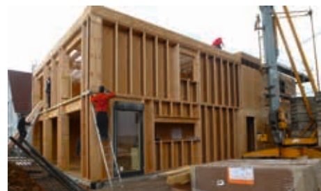
Construction de l'étage : la structure en lamibois et poutres en I est beaucoup plus légère qu'un bâtiment en maçonnerie. Le poids de l'étage est soutenu par les murs extérieurs et les cloisons porteuses.
