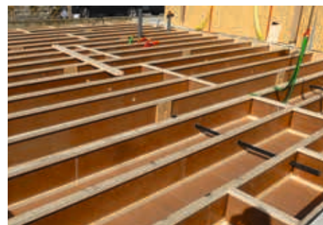
Les poutres sont prépercées pour faciliter le passage des gaines.
