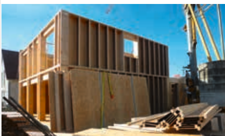
Construction de l'étage : la structure en lamibois et poutres en I est beaucoup plus légère qu'un bâtiment en maçonnerie. Le poids de l'étage est soutenu par les murs extérieurs et les cloisons porteuses.
