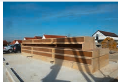
Caissons de plancher : cadre en STEICO LVL et poutres en I pour les solives
