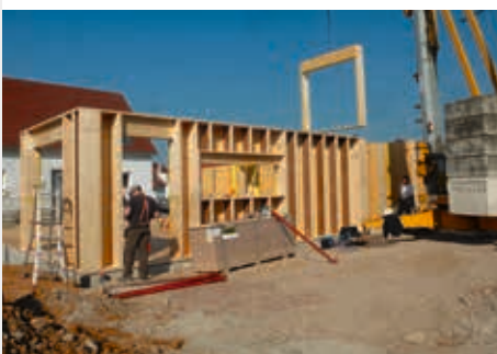
Les montants des ouvertures sont en STEICO LVL pour une meilleure reprise de charges.
