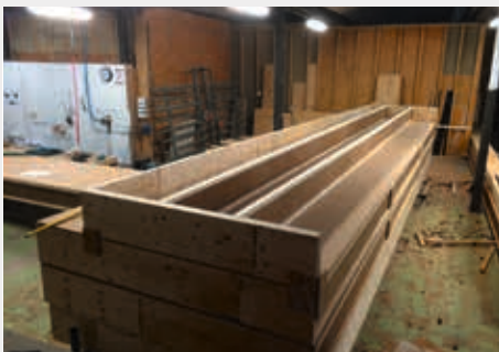
Les éléments de mur et de plancher sont préfabriqués en atelier et livrés sur le chantier.
