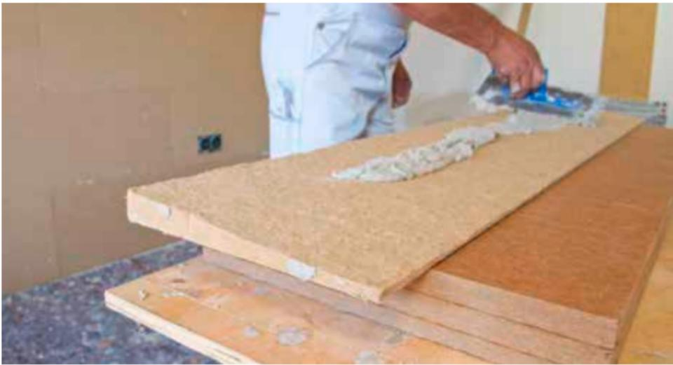
*STEICOtri* für die Flankendämmung
