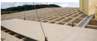
Großformatige Dachschalungen aus STEICO LVL X
