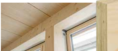
Unterzug und Stütze aus STEICO GLVL R
