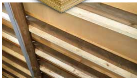
Seitliche Sparrenverstärkungen aus STEICO LVL R
