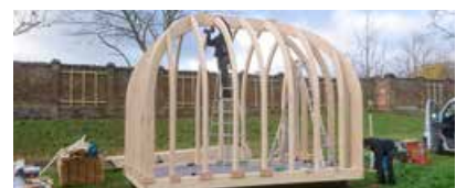
Außergewöhnliche Tragwerke aus STEICO LVL X
