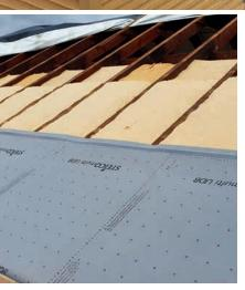
Holzfaser-Dämmstoffe wie die STEICOflex 036 sind sorptiv: Sie können viel Feuchte aufnehmen, zwischenspeichern und dann wieder abgeben, wobei sich ihre Dämmfähigkeit kaum verändert. Bei der Dachsanierung von außen lässt sich dadurch häufig auf eine kompliziert zu verlegende Dampfbremsbahn verzichten. Für die Bewohner bedeutet das: kurze Bauzeiten mit nur geringen Beeinträchtigungen.
