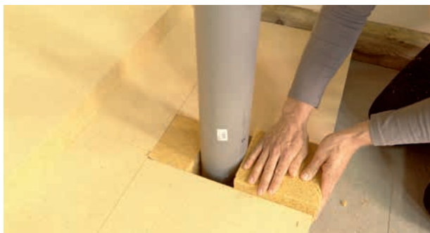
Der Raum zwischen zwei STEICO top -Dämmplatten wird mit großen ...
