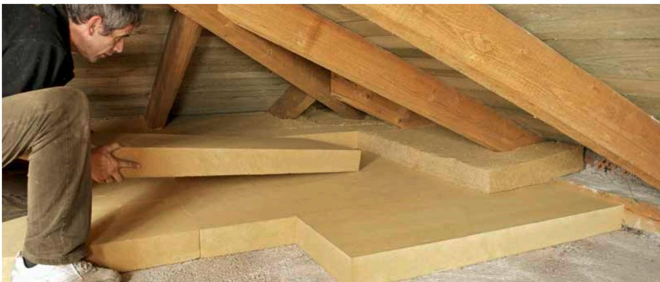
Nel caso in cui il sottotetto dell'edificio non sia abitabile, è possibile isolare termicamente l'ultimo piano abitato tramite la posa di pannelli rigidi STEICOTop all'estradosso dell'ultimo solaio. Se il solaio superiore non assolve la funzione di freno a vapore, si rende necessaria la posa di una membrana freno a vapore (STEICOMulti cover 5) tra l'isolante e il solaio.
