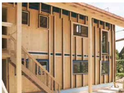
Realizzazione di uno strato isolante sulla parete in legno massiccio utilizzando STEICOjoist come sottostruttura resistente al taglio.
