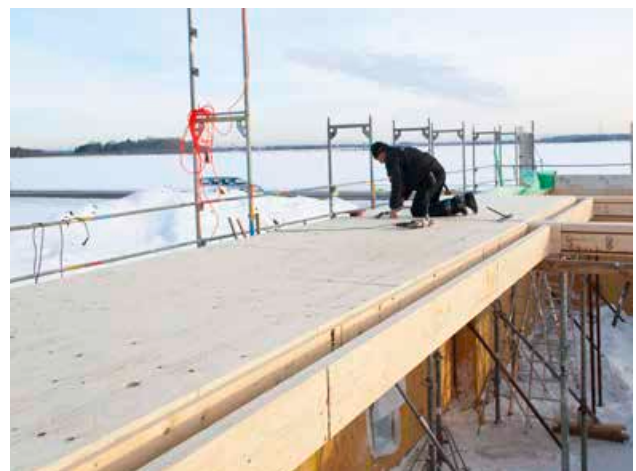
STEICO LVL X usato come lastra rigida nella costruzione di elementi di solaio.
