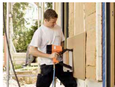
Isolamento dei vani a parete con STEICOflex. Chiusura del vano con STEICOuniversal come secondo strato portante d'acqua dietro la cassaforma in legno di larice.
