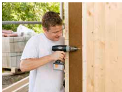
Fissaggio dei travetti STEICOjoist con viti per legno attraverso il corrente posteriore.
