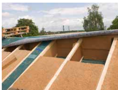
Vista del livello di isolamento della struttura del tetto. Travetti STEICOjoist preisolati con pannelli isolanti STEICOflex.
