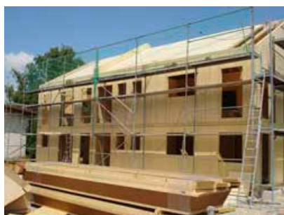
Le travi STEICOjoist già pretagliate, sono in attesa di essere installate sul tetto.
