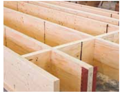
Prefabbricazione di elementi scatolari e nervati.
