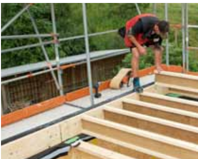
Come travi di bordo (in combinazione con STEICOjoist).
