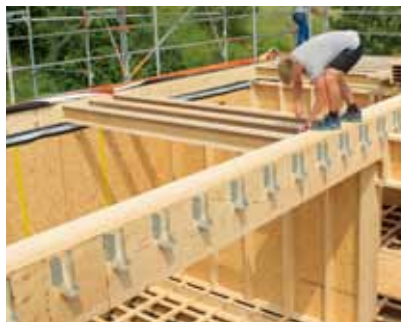
Come trave principale (in sostituzione di profili in acciaio).
