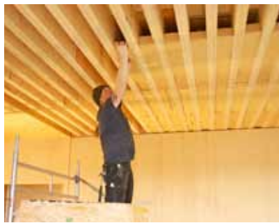
Realizzazione di solai di ampie campate in edifici commerciali.
