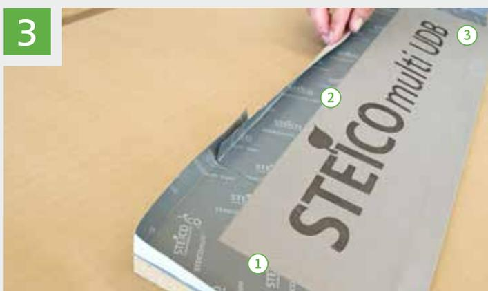
3 In seguito vanno applicate le strisce incollanti STEICO*multi tape F* sul cuneo in modo tale che si realizzi una "vaschetta" a tre lati.
