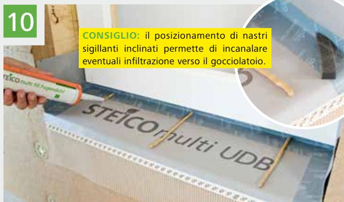
**CONSIGLIO:** il posizionamento di nastri sigillanti inclinati permette di incanalare eventuali infiltrazione verso il gocciolatoio.
