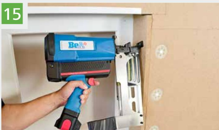
Fissare il pannello di stipite mediante graffe lunghe o viti in acciaio inossidabile al fine che la pressione favorisca il corretto indurimento di STEICOmultipill.
