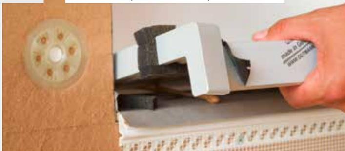
Costruzione della finestra. **CONSIGLIO:** la ripiegatura interna della lamiera si trova nella scanalatura della finestra, mentre invece la ripiegatura anteriore ha una distanza di < 3 cm dalla facciata intonacata.
