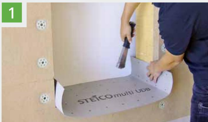
1 Applicazione di STEICO*multi UDB* (membrana traspirante) come protezione temporanea alle intemperie fino al montaggio della finestra.
