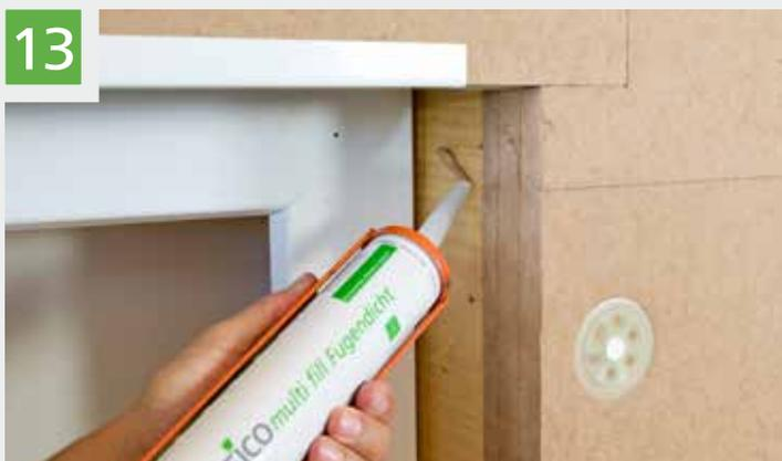
Applicazione delle strisce di collante STEICOmultipill nel telaio della struttura per garantire una miglior tenuta dei pannelli costituenti lo stipite.
