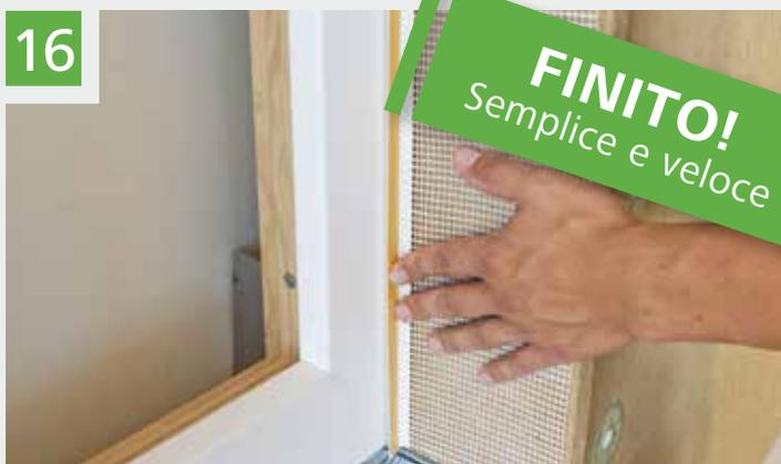
Applicazione di un adeguato profilo porta intonaco per una sicura finitura dell'intonaco e prosecuzione dei lavori per la realizzazione del cappotto.
