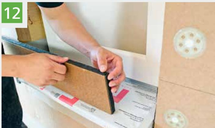
Montaggio dello stipite. Protezione aggiuntiva contro la pioggia fornita grazie all'applicazione di nastri sigillanti sulle tre superfici laterali da fissare.
