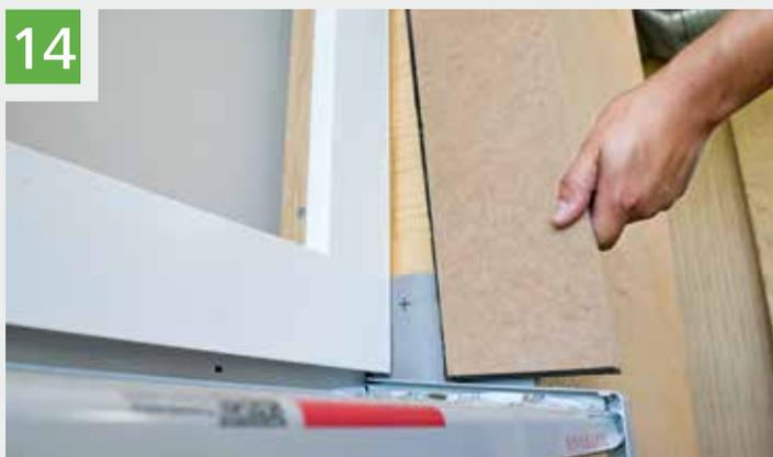
Inserire il pannello laterale a livello dello spigolo inferiore delle parete intonacata. **CONSIGLIO:** eventualmente pianificare un ampliamento dell'infisso.
