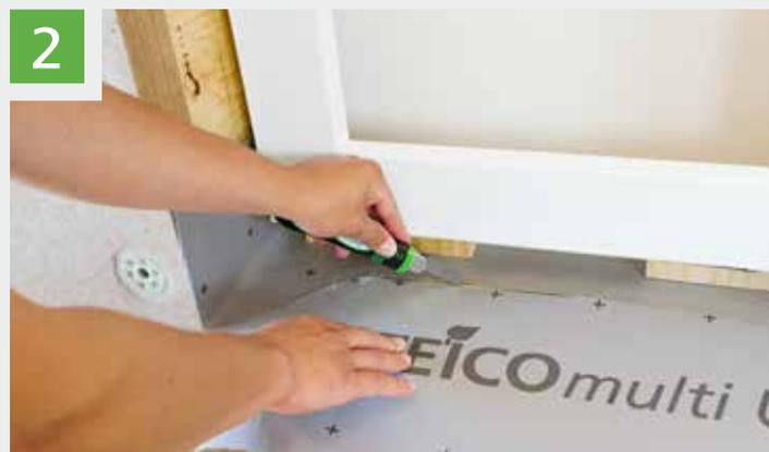
2 Il montaggio della finestra avviene sopra la membrana traspirante. Prima del montaggio di STEICO*fix* la membrana deve essere tagliata a forma di "mezzaluna".
