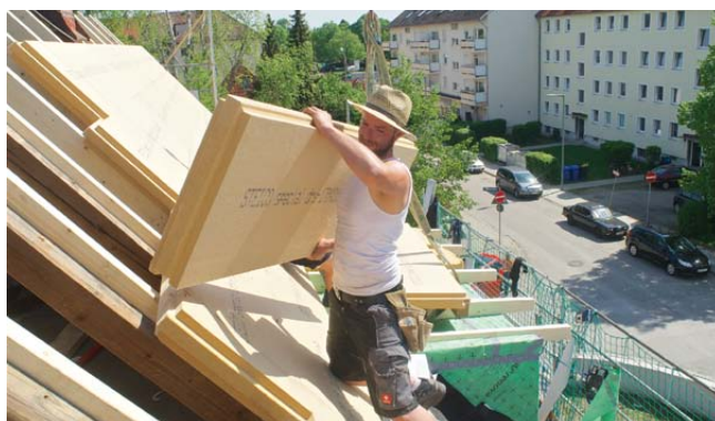
Format płyt został tak zaprojektowany, aby umożliwić prosty montaż. STEICOspecial dry mają specjalny profil pióro-wpust, który znacznie przyspiesza i ułatwia proces łączenia. Fot. STEICO
