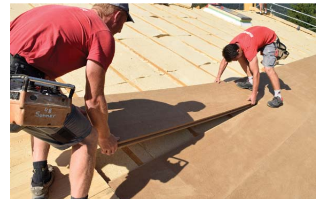
Prowadzone od zewnątrz prace modernizacyjne przebiegają sprawnie i w niekropotliwy dla mieszkańców sposób. Fot. STEICO
