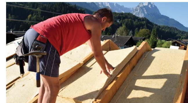
Montaż mat STEICOflex 036 polega na ich wciśnięciu pomiędzy krokwie. Dzięki porowatej strukturze i sprężystości przylegają dokładnie do izolowanych powierzchni. Fot. STEICO
