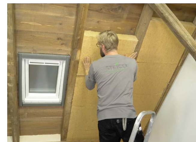
Dzięki porowatej strukturze i sprężystości maty STEICOflex 036 dokładnie przylegają do izolowanych powierzchni. Fot. STEICO
