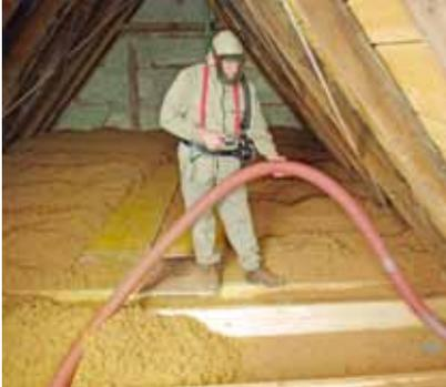
Se trata de un procedimiento de aislamiento térmico por soplado de fibras de madera de suelos estancos al aire de buhardillas no acondicionadas o de
