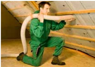
Se trata de un procedimiento de aislamiento térmico por insuflado de fibras de madera de entramados cerrados de cubiertas, muros o forjados para locales con humedad baja o media de edificios de viviendas o no residenciales nuevos o antiguos.
