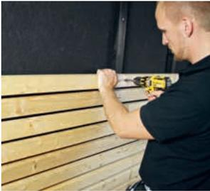
Eine horizontale Verarbeitung ist zu bevorzugen. Der Schutz vor Witterungseinflüssen ist gegeben, wenn die Fugenbreite  $7\text{ mm}^1 < b_f < 20\text{ mm}$  beträgt und die Deckbreite der Holzschalung mind. die dreifache Fugenbreite ( $3 \cdot b_f$ ) aufweist,
