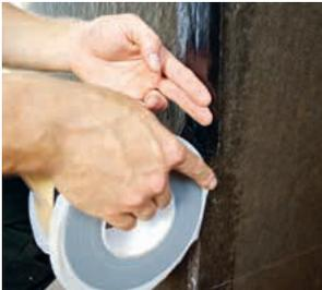
Stumpfe Stöße (Eckbereich), Anschlüsse an andere Bauteile, Durchdringungen etc. sind sorgfältig mit STEICO*multi tape black* abzukleben. Als Klebefläche je Stoßfugenseite sind ca. 50 mm auszuführen.
