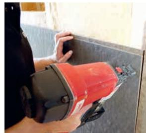
Die Montagebefestigung erfolgt mit Nägeln oder Klammern, die dauerhafte Lagesicherung erfolgt mit der Verschraubung der vertikalen Konterlatte in die Tragkonstruktion der Wand. Die Verwendung von nicht rostenden Verbindungsmitteln wird empfohlen. Nageldichtungsbänder unterhalb der Konterlattung sind nicht erforderlich.
