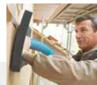
Beim Befüllen mit der Einblasnadel hinter gitterverstärkten Bahnen (z.B. STEICO *multi membra 5*) kann in der Regel auf einen Abdichtschwamm verzichtet werden, da die Bahn die Abdichtung übernimmt.
