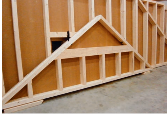
Fertig beplante Giebelwände bereit für die Verladung; Aussteifung während der Bauphase und Witterungsschutz
