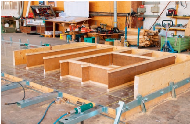
Die Rippen (STEICO Stegträger und STEICO LVL) der Wandtafel werden nach Plan zusammengefügt
