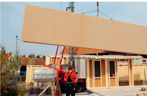
Außenansicht; vor Witterung geschützte, diffusionsoffene Wandtafel
