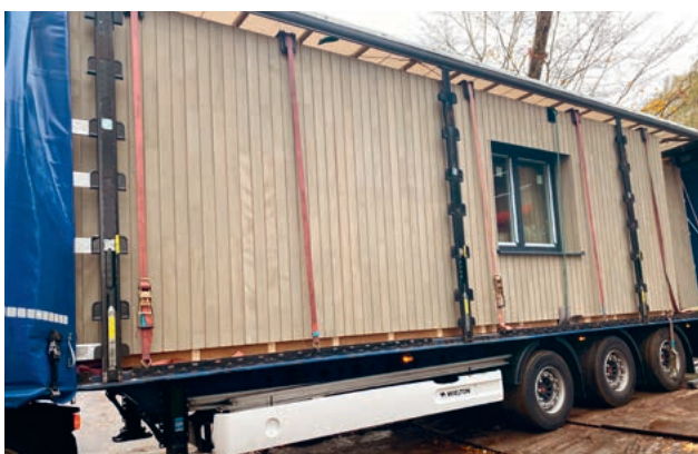
Anlieferung der einseitig offenen durch die STEICOuniversal ausgesteiften Elemente auf der Baustelle
