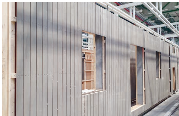
Das Fassadenelement inkl. Fassadenschalung bereit für den Fenstereinbau im Werk
