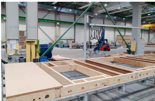
Das Riegelwerk aus STEICOjoist und STEICO LVL R wird mit der STEICOuniversal belegt, welche die Aussteifung während Transport und im Montagezustand sicherstellt
