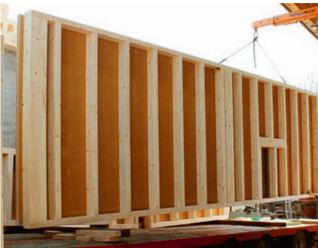
Einseitig beplantes Wandelement bei der Verladung, ausgesteift durch die STEICOprotect H
