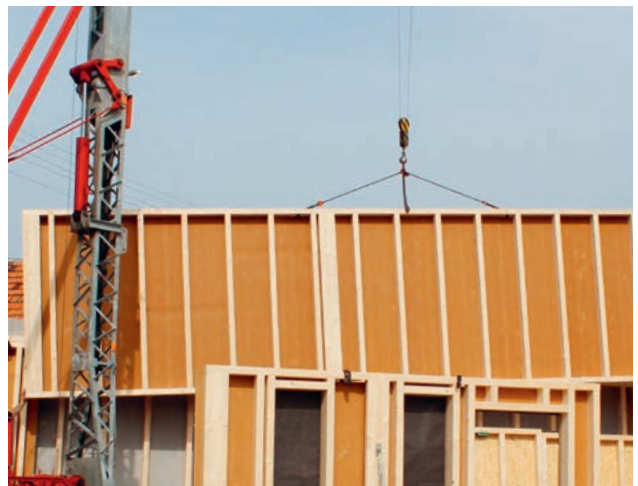
Montagefertiges Wandelement am Kranhaken, für Montage bereit
