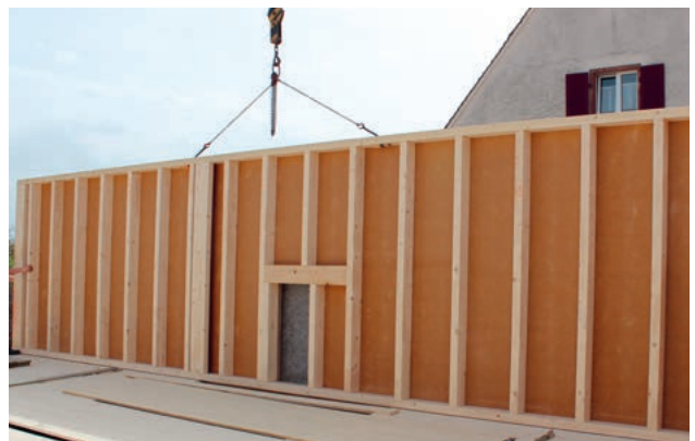
Erste Wand des Ausbauhauses bei der Baustellenmontage
