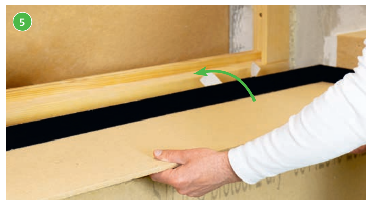
5 Einbau STEICOtri Dämmkeil: Unter Druck satt in den Kleber einschwimmen TIPP: Trennpapier zurückfalten für einfache Entfernung
