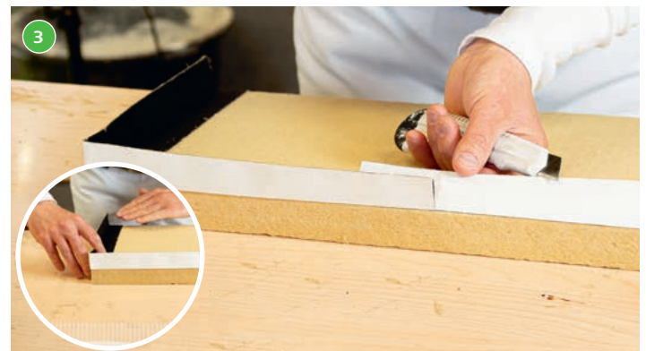
3 Die STEICO multi tape black Klebestreifen sollen mind. 5,0cm überlappen, so dass eine dichte, dreiseitige Wanne ausgebildet wird
