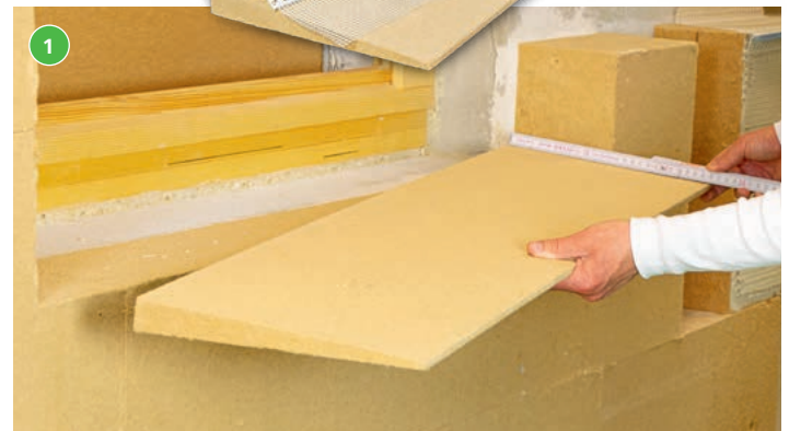
1 Bündiger Zuschnitt des STEICOtri Dämmkeils auf die passende Länge und Tiefe der Fensteröffnung
