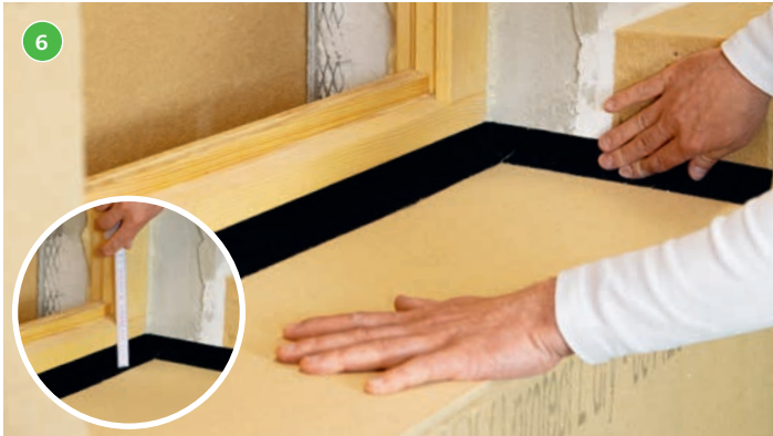
Höhenivellierung, restliches Abziehen des Trennpapiers und Andrücken des STEICO multi tape black umlaufend
