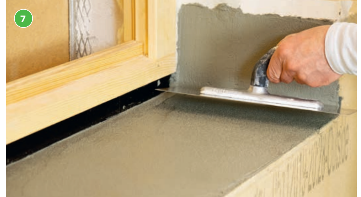
Danach Vorziehen des gesamten Keils, sowie des unteren Laibungsbereichs mit STEICO secure Base Guard
