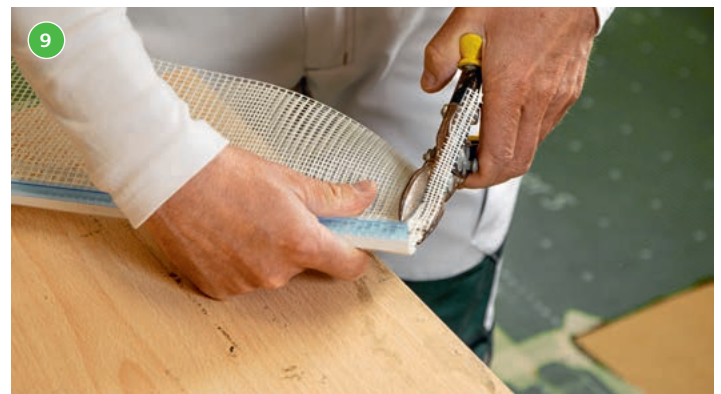
Zuschnitt von STEICO secure Mesh 4x4 , Gewebeeckwinkel, Abschlussprofil FB
