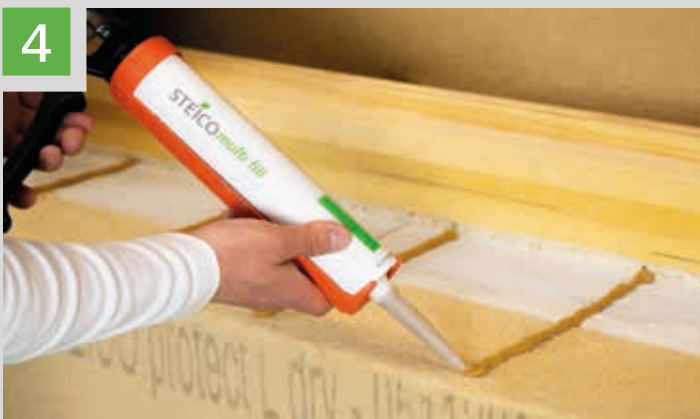
Kleben des Keils je nach Einbauhöhe mit STEICOmulti fill in Kleberaupen oder STEICOsecure Base mittels Klebebatzen, e \leq 20,0\text{cm}
