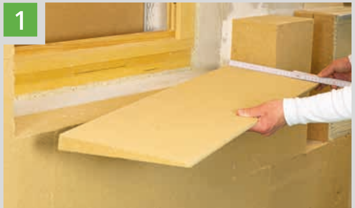
Bündiger Zuschnitt des STEICOtri Dämmkeils auf die passende Länge und Tiefe der Fensteröffnung.
