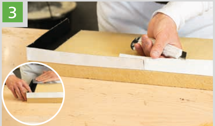
Die STEICOmulti tape black Klebestreifen sollen min. 5,0 cm überlappen, so dass eine dichte, dreiseitige Wanne ausgebildet wird
