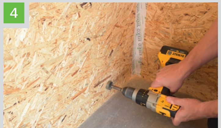
4 Im selben Gefach wie in Bild 3 wird unten, knapp über der Schwelle ein passendes Loch für die Installationszuführung gebohrt (z.B. 35 mm für Leerrohr).
