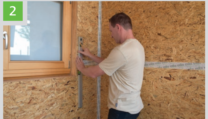
2 Die Größe des Ausschnittes beträgt 14 x 28 cm (B x H). Die Box kann sowohl horizontal als auch vertikal eingebaut werden.
