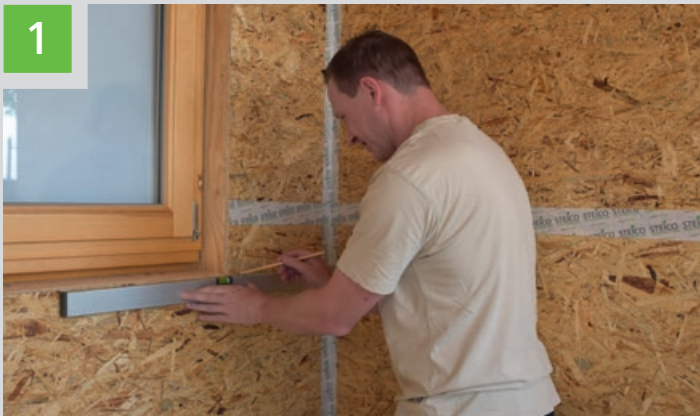
1 Lage und Position der Aussparung für die STEICOMulti box festlegen und markieren.
