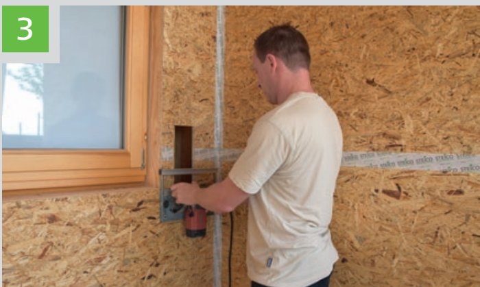
3 Ausschneiden der luftdichten Ebene (Plattenwerkstoff/Dampfbremsebahn).
