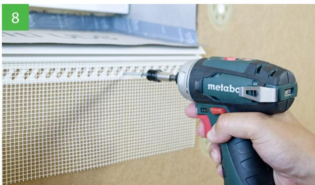
8 Fixation du profil goutte d'eau et du treillis d'armature sous l'appui de fenêtre à l'aide de vis ou d'agrafes en acier dans le panneau isolants.
