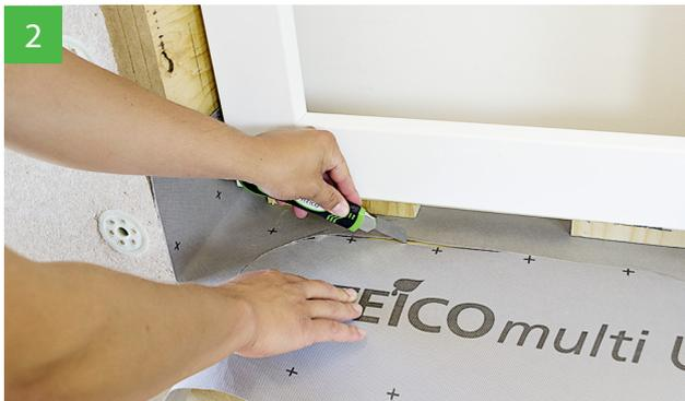
Le montage de la fenêtre se fait sur la membrane. On découpe la partie extérieure en arrondissant les angles (cf image 5).
