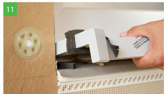
11 Pose de l'appui de fenêtre. Prévoir un débord de l'appui de 3 cm minimum par rapport à la façade enduite. **Astuce:** Garder les compribandes au frais afin d'éviter une dilatation trop rapide.
