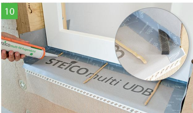
10 Encollage du support d'appui STEICOfix par des cordons de mastic-colle STEICOmulti fill espacés de 30 cm max. **Astuce:** les compribandes collées en biais permettent d'évacuer l'humidité vers le profil goutte d'eau
