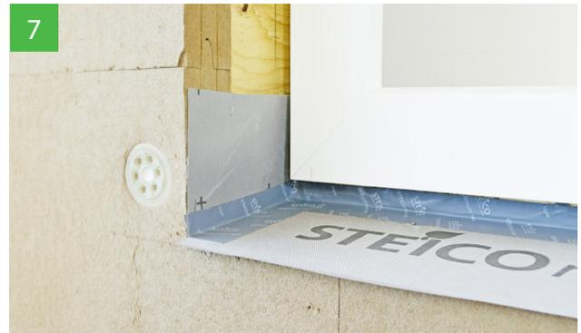
7 Mise en œuvre du complexe au niveau de l'appui de fenêtre. Liaison des remontées du STEICOmulti tape F avec les tableaux.
