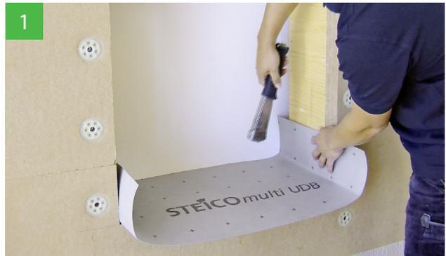
Recouvrir l'appui sur toute sa largeur avec la membrane d'étanchéité STEICO multi UDB pour protéger la construction des intempéries.
