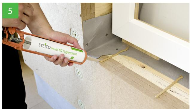
Appliquer le mastic colle STEICO multi fill au niveau de l'appui. L'espacement maximal des cordons de mastic-colle est de 30 cm.
