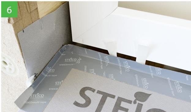
6 Mise en place de STEICOfix. **Astuce:** replier les bandes détachables au dos de l'adhésif, elles seront plus faciles à retirer par la suite.
