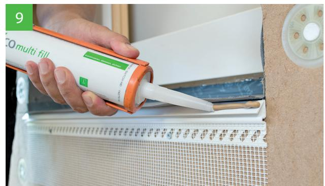
9 Le rabat de la membrane est collé au profil goutte d'eau du treillis d'armature avec du STEICOmulti fill.
