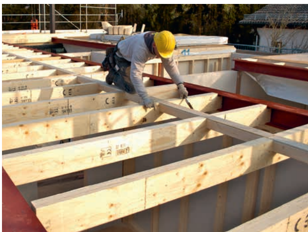
STEICO LVL R bei der Konstruktion von Deckentragwerken.
