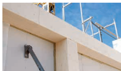
Primärtragwerk aus STEICO GLVL R Unterzügen und Stützen
