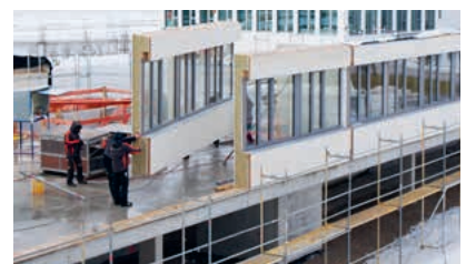
Die vorverputzten Wandelemente werden inklusive Fenster montiert.
