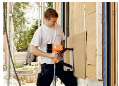
Ausdämmung der Wandgefache mit STEICO flex . Gefachabschluss mit STEICO universal als zweite wasserführende Schicht hinter der Lärchenholzschalung.
