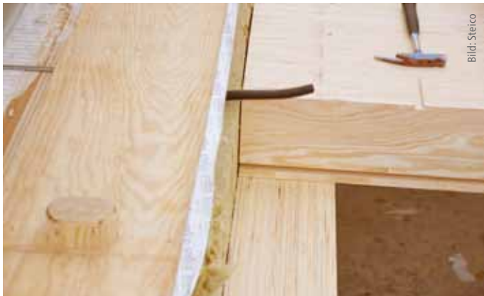
Die Deckenelemente liegen auf dem durchlaufenden Unterzug auf. Die vorgestellten Fassadenelemente werden mittels Winkelschuh an die Deckenelemente angebunden.
