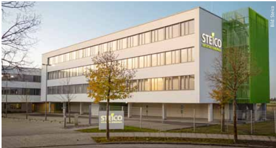
Der viergeschossige Erweiterungsbau einer Firmenzentrale mit Erdgeschoss in Massivbauweise und drei Etagen, die als reiner Holzbau ausgeführt sind, schafft zusätzliche 2120 m 2 Nutz- und Bürofläche.
