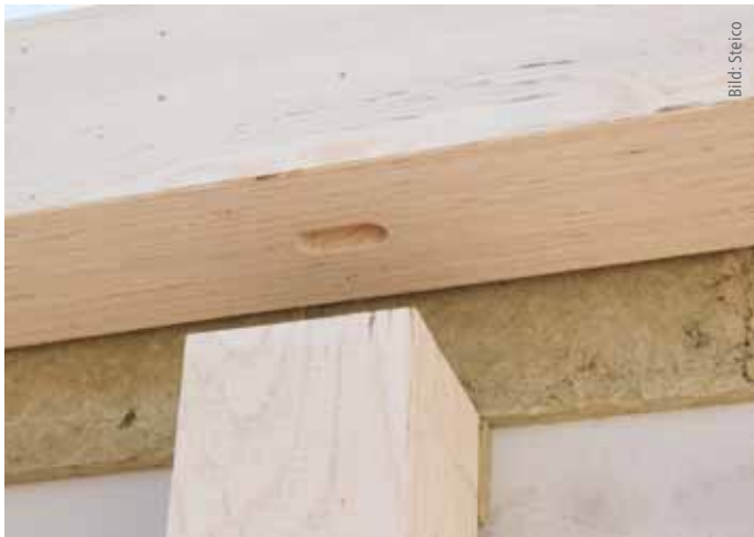
Montage der durchlaufenden Unterzüge aus verklebtem Furnierschichtholz mit einem Zapfen als Montagehilfe. In den Leibungsbereichen ist die Finitionsoberfläche sichtbar.
