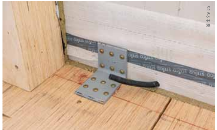
Die Deckenelemente liegen auf dem durchlaufenden Unterzug auf. Die vorgestellten Fassadenelemente werden mittels Winkelschuh an die Deckenelemente angebunden.
