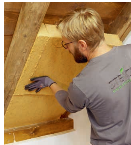
Holzfaser-Dämmmatte STEICOflex als Zwischensparrendämmung
