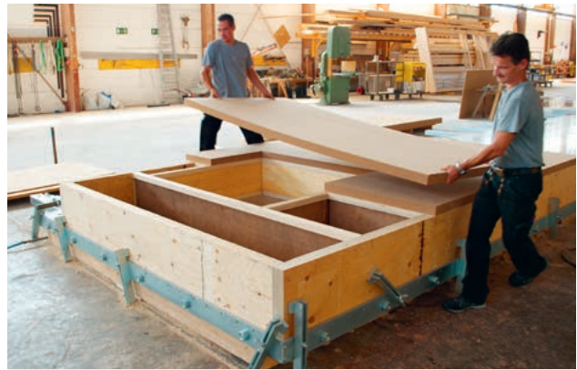
Bepunktung mit STEICOprotect H. Aussteifung während der Bauphase und Witterungsschutz
