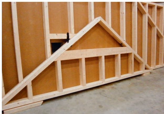
Fertig beplante Giebelwände bereit für die Verladung; Aussteifung während der Bauphase und Witterungsschutz
