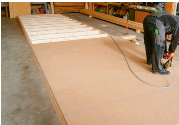
Bepunktung einer Erdgeschosswand mit der aussteifenden STEICOprotect H
