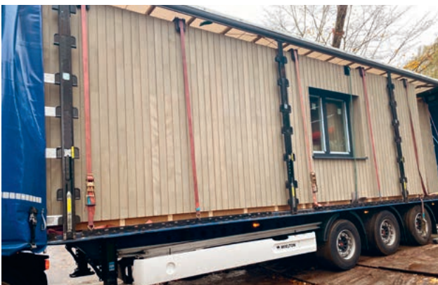
Anlieferung der einseitig offenen durch die STEICOuniversal aussteiften Elemente auf der Baustelle
