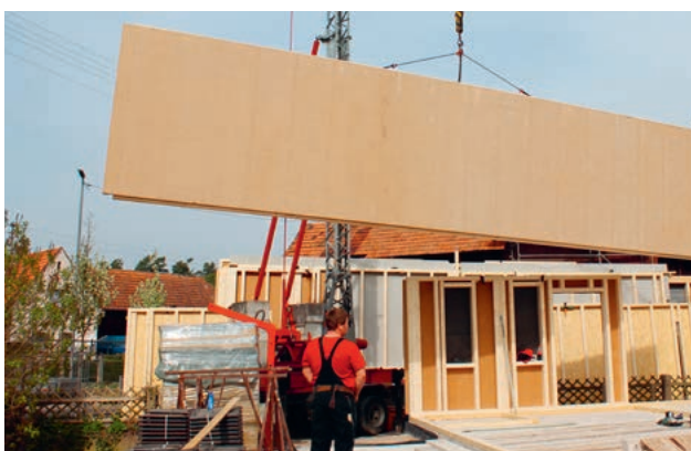
Außenansicht; vor Witterung geschützte, diffusionsoffene Wandtafel
