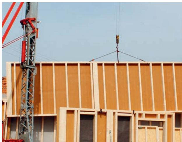
Montagefertiges Wandelement am Kranhaken, für Montage bereit
