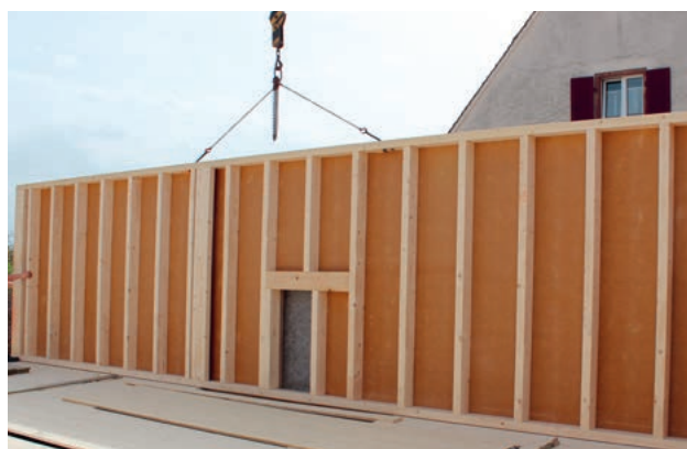
Erste Wand des Ausbauhauses bei der Baustellenmontage
