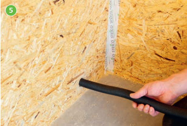
Ein Leerrohr durch das Loch in Richtung rechteckigen Ausschnitt schieben.
