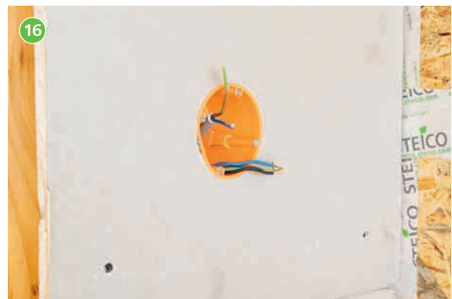
16 Montage der Kabel an den Schalter, Steckdose etc...
