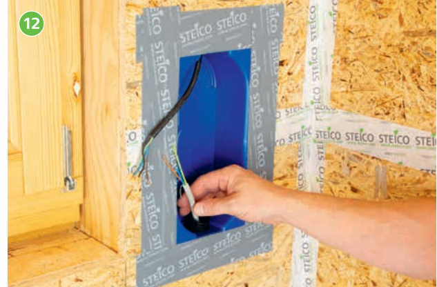
12 Alle an- und abgehenden Leitungen treffen sich in der STEICO multi box.
