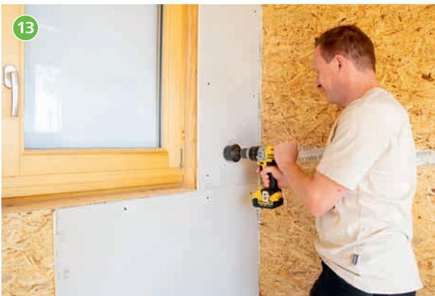
13 Nach dem Anbringen der Schlussbeplankung werden die Dosen gebohrt, \varnothing 68 mm.
