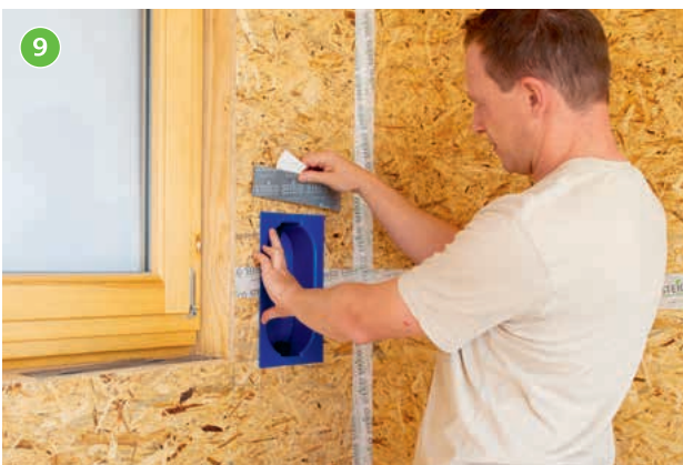
Mit STEICOMulti tape (Typ F oder P) wird die STEICOMulti box mit der Holzwerkstoffplatte bzw. Dampfbremse luftdicht verklebt.
