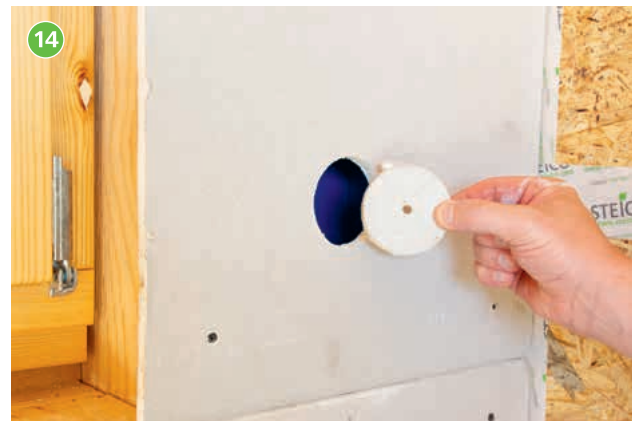
14 Plattenrest entfernen und Kabel herausziehen.
