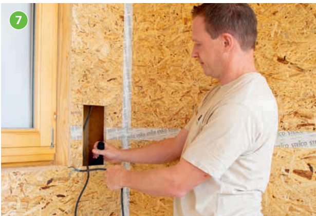
Das Ende des Leerrohres durch den rechteckigen Ausschnitt führen. Sollen weitere Leerrohre/Leitungen von der Box abgehen, können auch diese gleich mit in den Ausschnitt gezogen werden.
