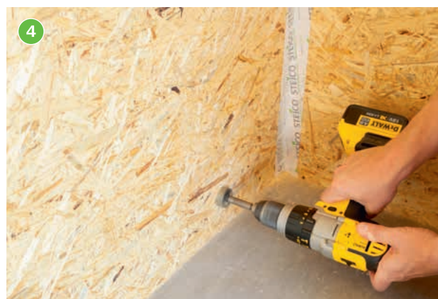
4 Im selben Gefach wie in Bild 3 wird unten, knapp über der Schwelle ein passendes Loch für die Installationszuführung gebohrt (z.B. 35 mm für Leerrohr).
