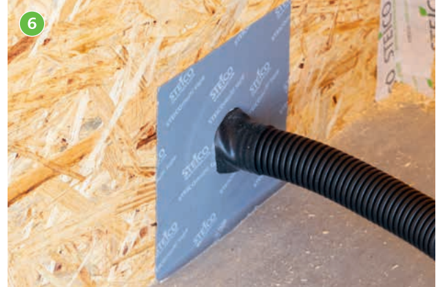
Leerrohr mit Hilfe der selbstklebenden Manschette abdichten. Alternativ kann auch mit Klebeband schuppenförmig abgedichtet werden.
