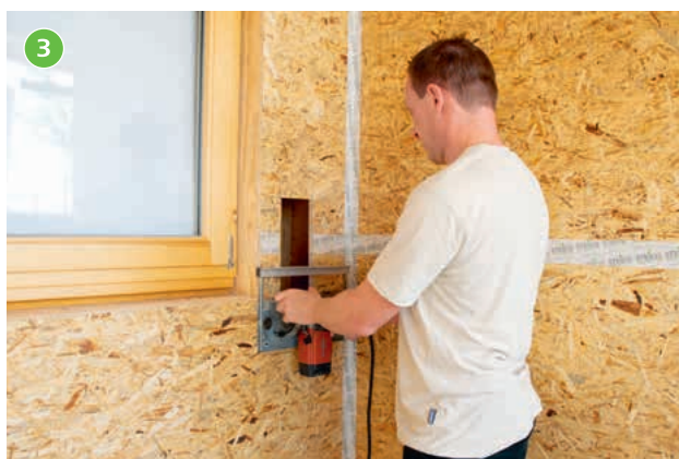
3 Ausschneiden der luftdichten Ebene (Plattenwerkstoff/Dampfbremsebahn).
