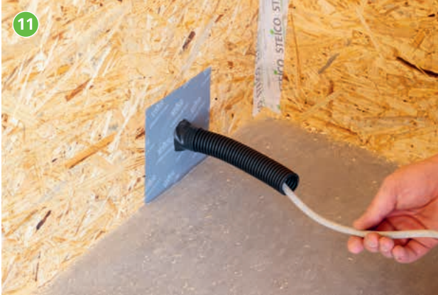
11 Installationsleitungen können nun durch das Leerrohr verzogen werden. Es können je nach Dicke, bis zu 5 Leitungen geführt werden.
