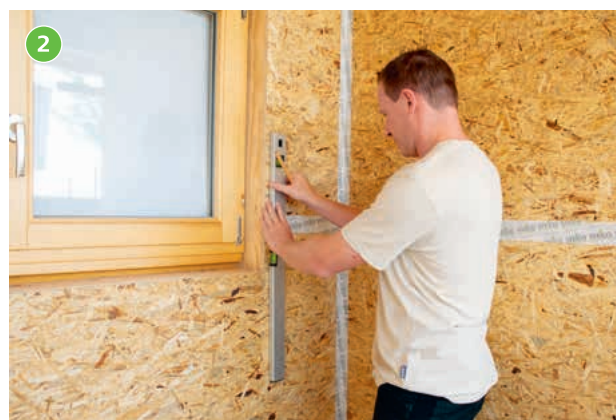
2 Die Größe des Ausschnittes beträgt 14 x 28 cm (B x H). Die Box kann sowohl horizontal als auch vertikal eingebaut werden.
