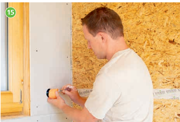
15 Montage der Hohlwanddose.
