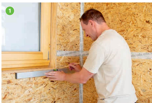
1 Lage und Position der Aussparung für die STEICO multi box festlegen und markieren.
