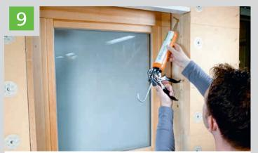
Aufbringen von STEICO*multi fill* Kleberaupen in die Holzrahmen-Konstruktion, um einen sicheren Halt der Laibungsplatte zu gewährleisten.
