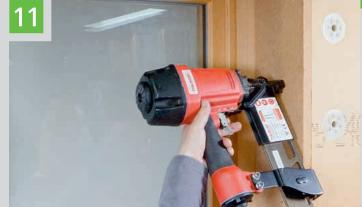
Fixierung der Laibungsplatte mittels Breitrückenklammern oder Edelstahlschrauben (Anpressdruck zur ungestörten Aushärtung von STEICO*multi fill*)
