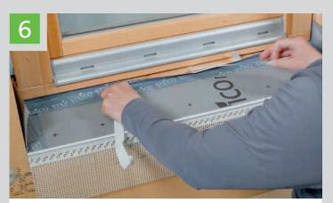
Einsetzen des STEICO*fix 2.0* auf die Brüstung, restliches Abziehen des Klebeband-Trennpapiers und Andrücken des STEICO*multi tape F* Klebebandes.
