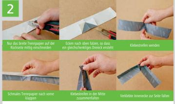
Zur Ausbildung der Ecken die Klebestreifen in doppelter Breite des Dämmkeils ablängen. Anschließend folgen die oben beschriebenen Schritte.
