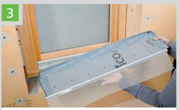
Im Anschluss die STEICO*multi tape F* 20/40 mm Klebestreifen so auf dem Dämmkeil anbringen, dass eine dreiseitige "Wanne" ausgebildet wird.
