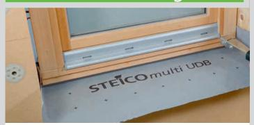
Die diffusionsoffene Unterdeckbahn STEICOmulti UDB wird auf der Konstruktion als temporärer Witterungsschutz vor dem Fenstereinbau angebracht. Hinweis: Rahmenverbreiterungen seitlich; Fensterstockaufdoppelungen unten sind für die notwendige Überdämmung sowie den Einbau des Holzfaserdämmkeiles ggfs. einzuplanen
