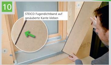
Einsetzen der Laibungsplatte bündig zur Außenkante der WDVS-Fassade.
