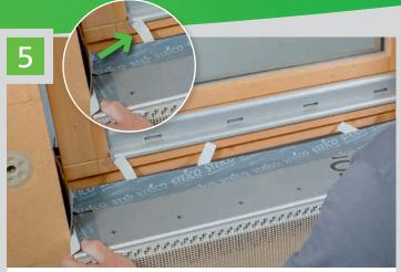
Einbau des STEICO*fix 2.0* Dämmkeils. **TIPP:** Trennpapier zurückfalten, es kann später leichter entfernt werden.
