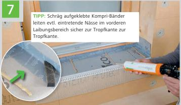
Auftragen von STEICOmulti~fill Kleberaupen e  $\leq$  30 cm für die dauerelastische Befestigung der Fensterbank.
