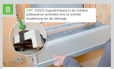
Einbau der Fensterbank. Die hintere Blechverfalzung befindet sich in der passenden Fensterrille, die vordere hat einen Abstand von mind. 3 cm zur Putzfassade.
