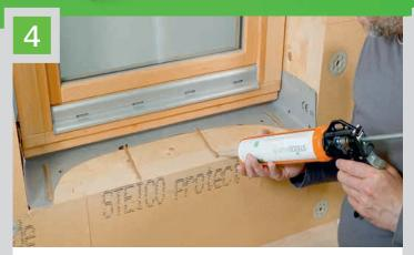
Als Abhebesicherung des Dämmkeils STEICO $multi\ fill$  Kleberaupen anbringen, e  $\leq$  30 cm.
