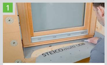
Vor Montage von STEICO fix 2.0 die Bahn trapezförmig zurückschneiden
