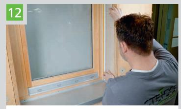
Setzen der Anputzleiste auf gereinigten Fensterrahmen gegen die Holzfaserdämmplatte.
